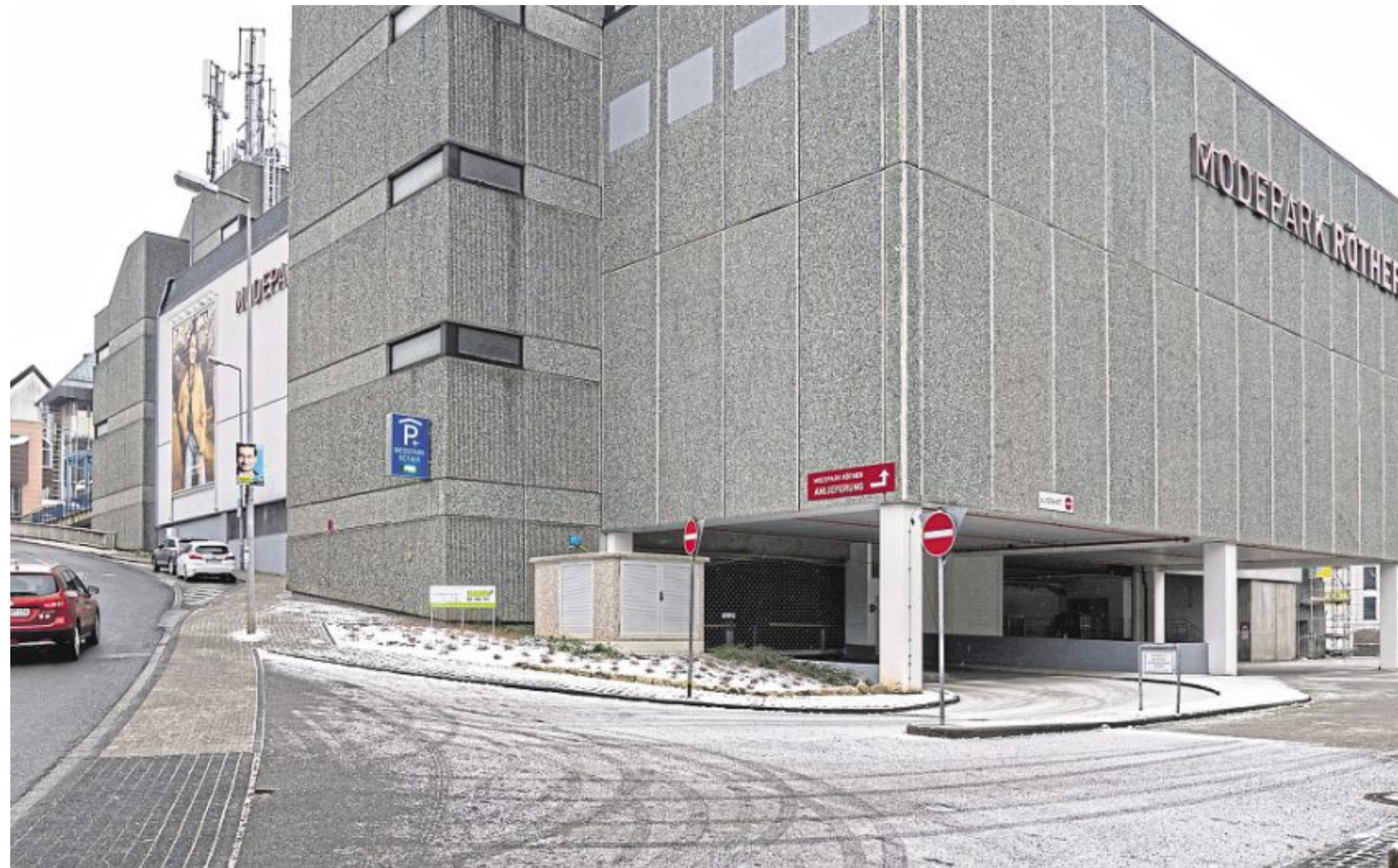
Die Tiefgarage unter dem Modepark Röther ist nach wie vor die wichtigste Parkgelegenheit in Idar-Oberstein. Das wird in Zeiten des Lockdowns zum Problem, weil das Modehaus geschlossen ist. Dennoch kann man ins Parkhaus gelangen. Rauszukommen, ist dagegen viel schwieriger... Foto: Hossler
